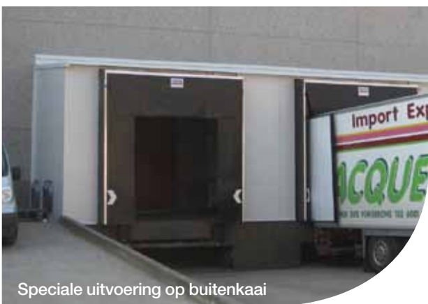
Grotere uitvoering aangepast aan het gebouw
